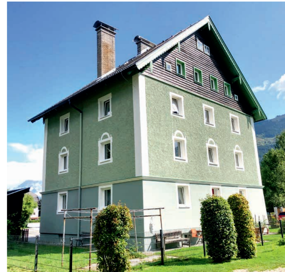
Das von der Malerei Kühar neu renovierte 84er Haus.
