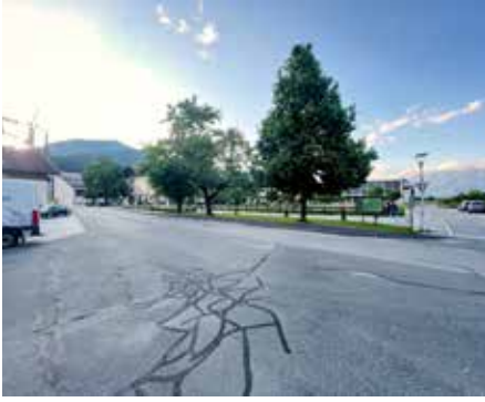
Neuer asphaltierter Gehsteig im Bereich Dorfstraße / Unterwirts-kreuzung.
