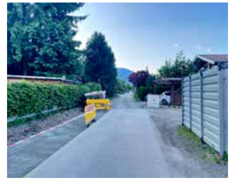
Die Arbeiten „Am Feld“ haben begonnen
