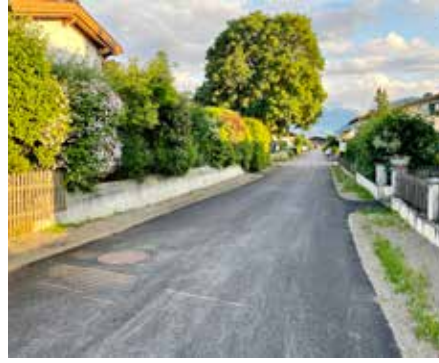
Fertig sanierte Straße beim Zenzfeld
