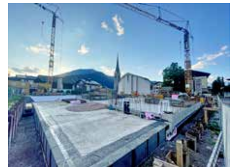
Die Bauarbeiten für das neue Gemeindegebäude sind im Zeitplan.
